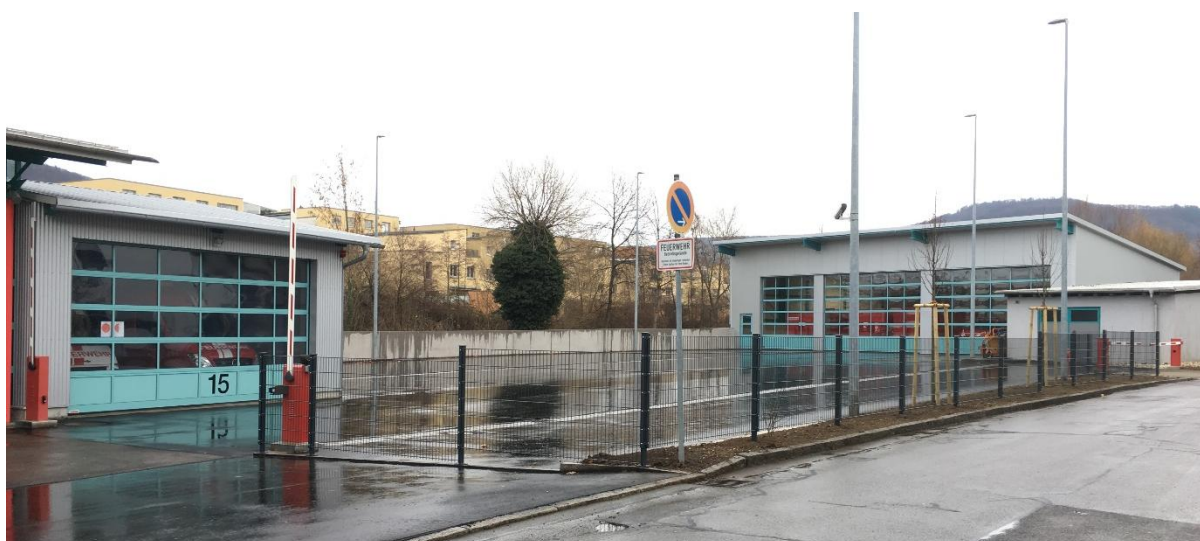
Abbildung 12: Übunghof am Feuerwehrhaus
