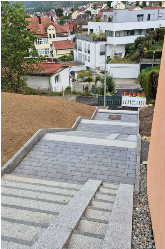
Neue Treppenanlage an vertrauter Stelle zwischen Rötsteige und Oberhaldenweg.
