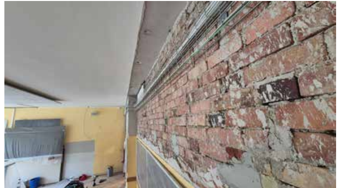
Klassenzimmer im FSG-A-Bau: Hier werden unter anderem die Elektroleitungen erneuert.
