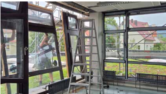
Entfernung der alten Fenster am WHR-Hauptgebäude.
