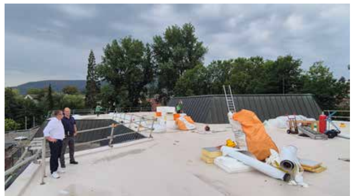
Erneuerung des Dachs des Echazbads.
