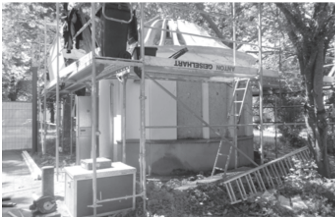
Arbeiten am Pavillon im Park (05/2025) wp
