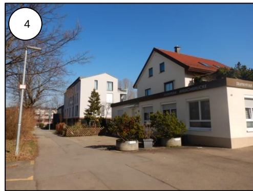
Gebäude Marktstraße 68, Blickrichtung N
