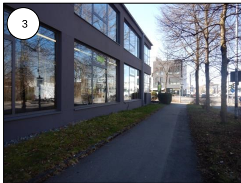
Gebäude Arbachstraße 2, Blickrichtung O
