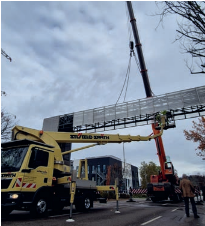
Bevor die Brücke per Kran von den Türmen abgehoben werden konnte, mussten zahlreiche Schrauben gelöst werden. (Fotos: Hehn/Metzger)
