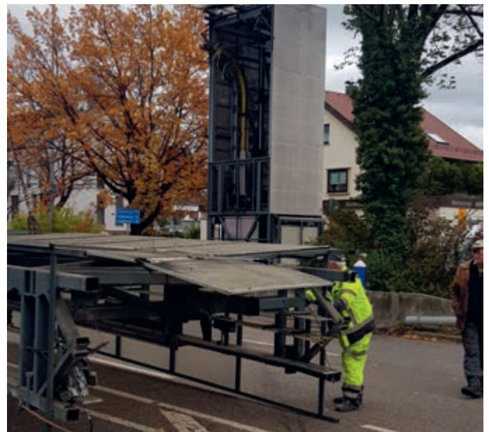
Noch an Ort und Stelle wird der Peoplemover in abtransportierbare Einzelteile zerlegt.
