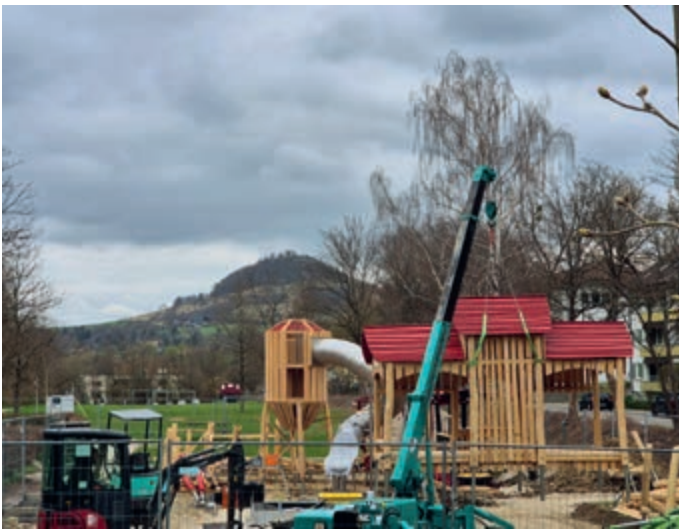
Bei den Bauarbeiten am Kinderspielplatz am Bahnhofsanger schwebt das künftige Bahnhofsgebäude aktuell noch in der Luft. (Foto: Hehn/Stadt)
