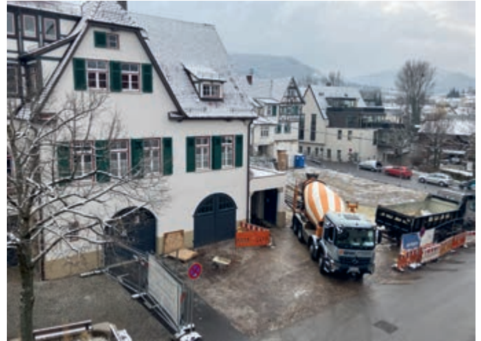
Unter anderem in der Garage hinter der orangenen Absperrung finden momentan die Fundamentarbeiten statt. (Foto: Stadt Pfullingen/Sinan Damar)
