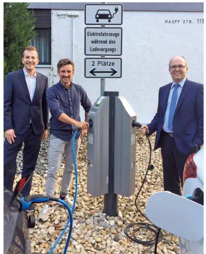
(Foto: Fritz Engelhardt) v.l.: Jörg Engelhardt, Micha Haußmann, der sein Auto an der neuen Ladesäule auflädt und Bürgermeister Michael Schrenk
