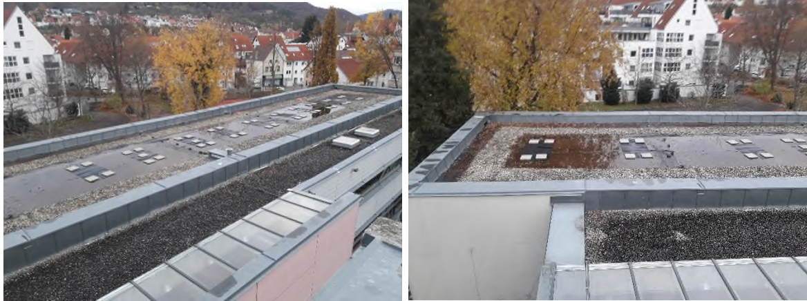
Bilder Dach C-Bau Stand März 2022
