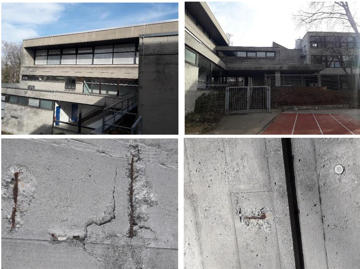
Die Fassade wird nach der Reparatur der Betonfläche komplett gereinigt, mit Tiefengrund grundiert und mit Acrylfarbe deckend gestrichen.
