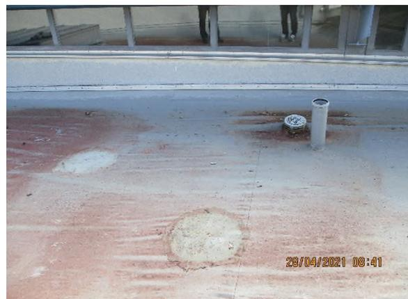
Das undichte Kiesflachdach wurde bereits im Herbst 2020 abgeräumt und provisorisch abgedichtet. Nachdem der Kies zur Auffindung der Schadstellen abgeräumt werden musste, ist die Sanierung des Flachdaches in 2021 durchzuführen, um weitere Wasserschäden im Gebäude zu vermeiden.
