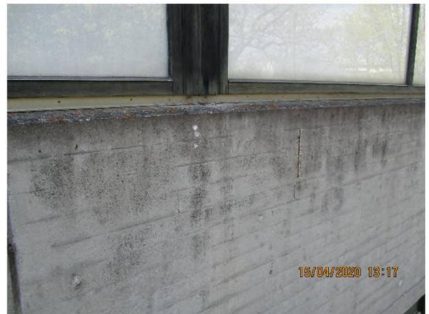
Die Betonfassade an der Ostseite der Turnhalle muss alters- und wetterbedingt saniert werden. Die entstandenen Betonrisse und die Abplatzungen im Bereich des mittlerweile freiliegenden Betonstahls müssen fachgerecht behandelt und verspachtelt werden.
